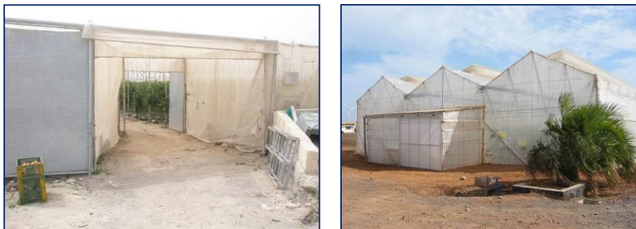
Figura 5: Dobles puertas en invernaderos, hacia dentro (izquierda) y hacia afuera (derecha).
